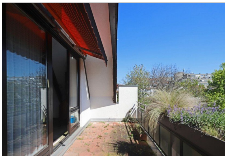
Balkon im OG
