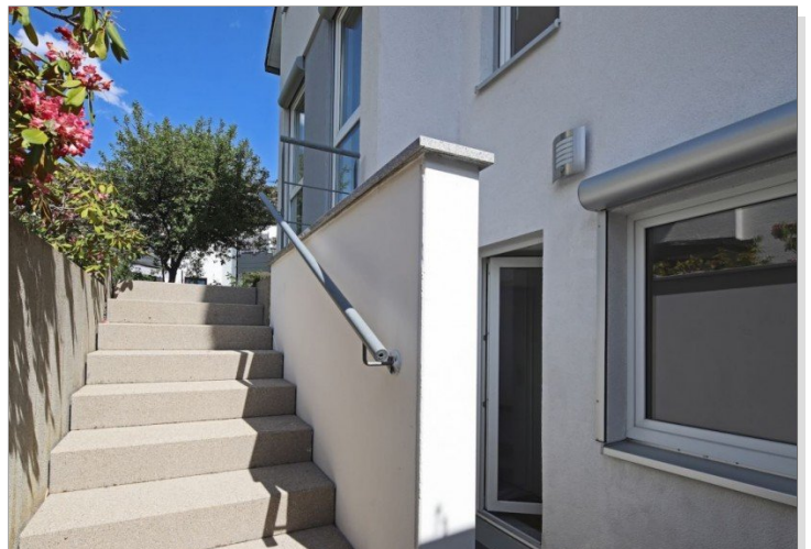
Eingang Einliegerbereich UG
