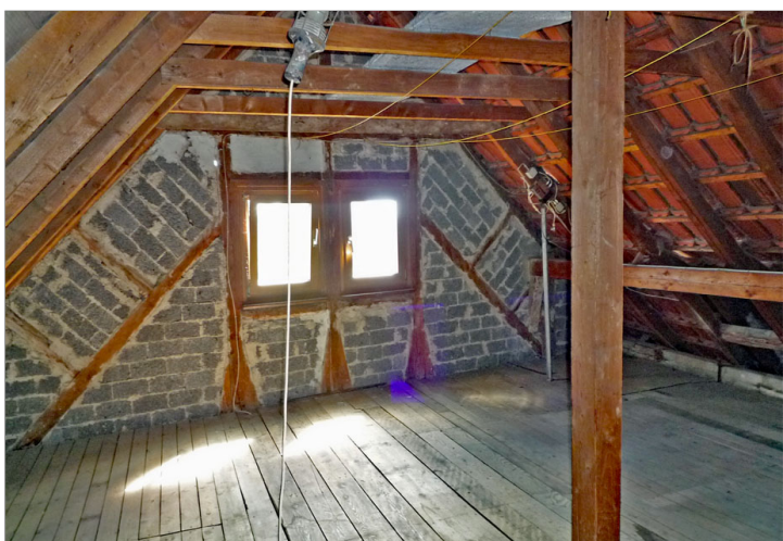
Dachboden im DG
