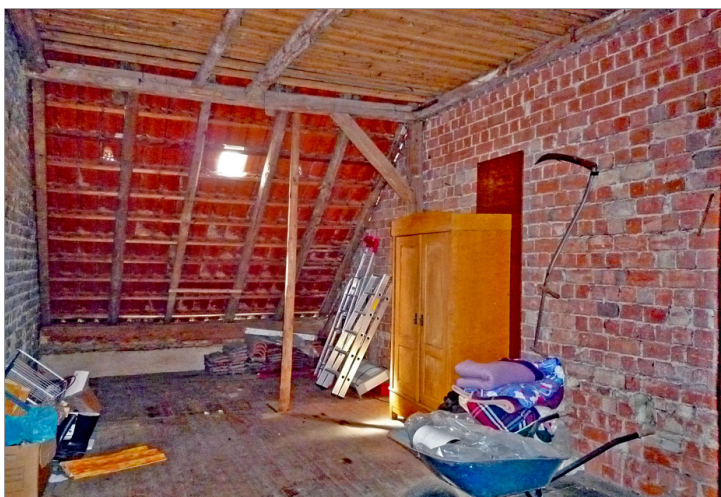
Bühnenzimmer im OG
